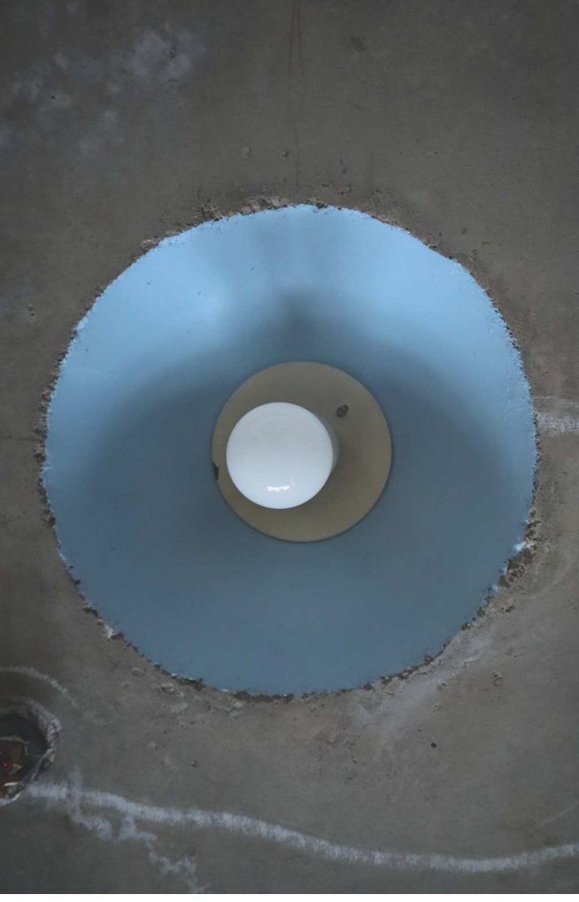
Välipohjiin on tehty upotuksia, joihin on asennettu lamppuja. Nykyiset led-polttimot eivät vastaa alkuperäistä tavoitetta, jossa polttimon valinnalla on ollut keskeinen rooli.
