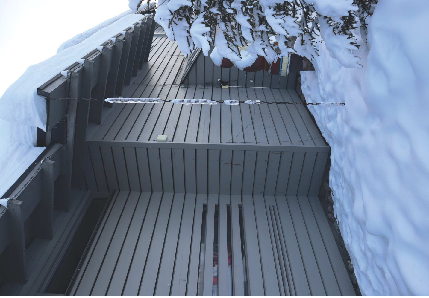
Ikkunoita on myös verhouksen takana. Nämä ikkunat ovat lähellä pohjoisjulkisivun vesikatton sadekourusta johtavaa sadekeijua.
