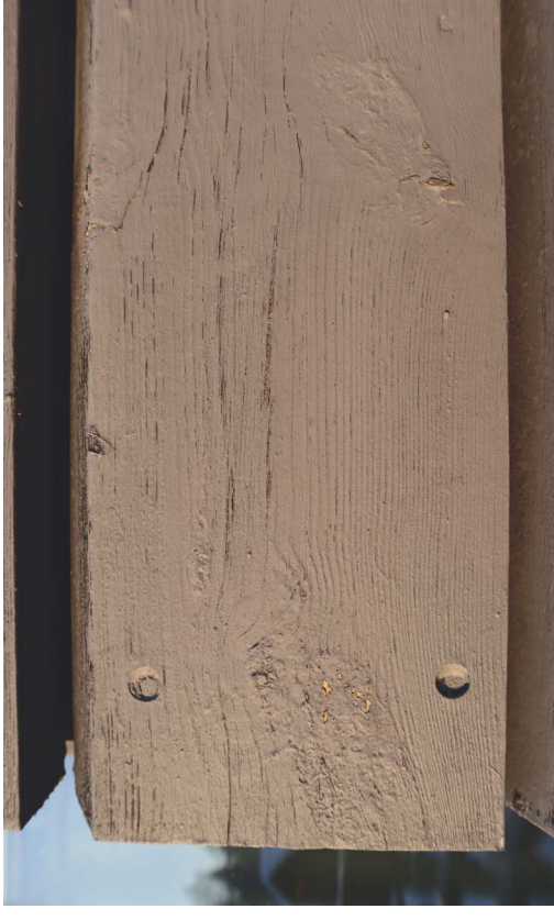
Julkisivun harmaa sävy on suojeltu. Nauloille on porattu esireiät, jolloin naulat asettuvat syvennyksiin.
